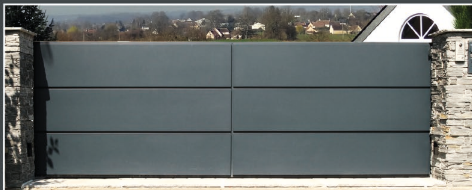
PHOTO DU PORTAIL INSTALLÉ CHEZ LE CLIENT
